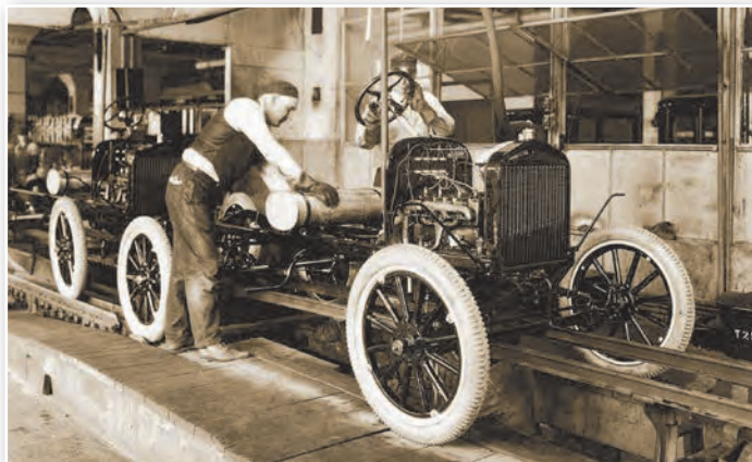
Конвейерное производство на заводе Форда. В 1913 г. Г. Форд запустил первый в мире автомобильный сборочный конвейер, что привело к повышению эффективности производства
